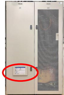
Figure 3 : exemple de la porte avant de la baie
