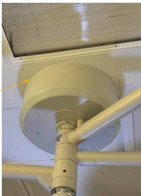
Figure 3: Exemple de cache plafond affleurant au plafond
