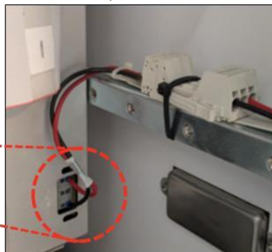
Figure 2 – Vue agrandie du câble d'alimentation Iris potentiellement
