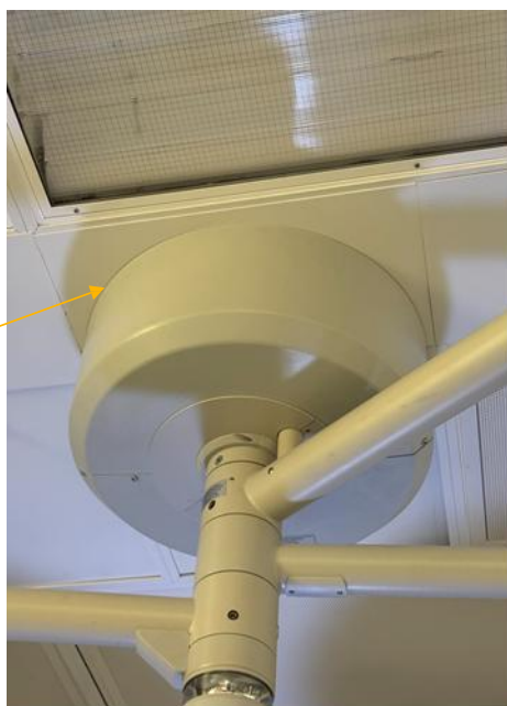
Figure 3: Exemple de cache plafond affleurant au plafond
